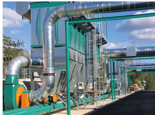
Baterías fi ltrantes modulares con limpieza mediante impulsos de aire comprimido
